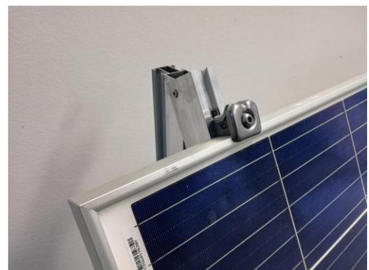
5. Die Befestigungsklemmen so justieren, dass diese am Modulrahmen aufliegt und mit einem Inbus festziehen.
